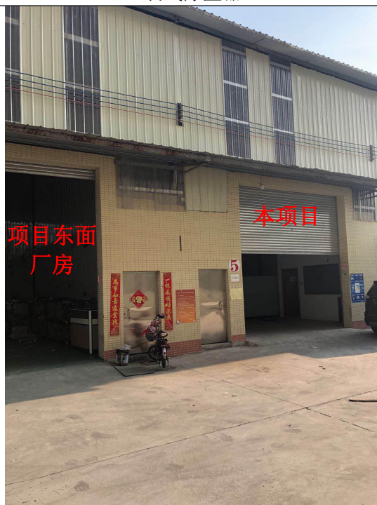
项目东面厂房
